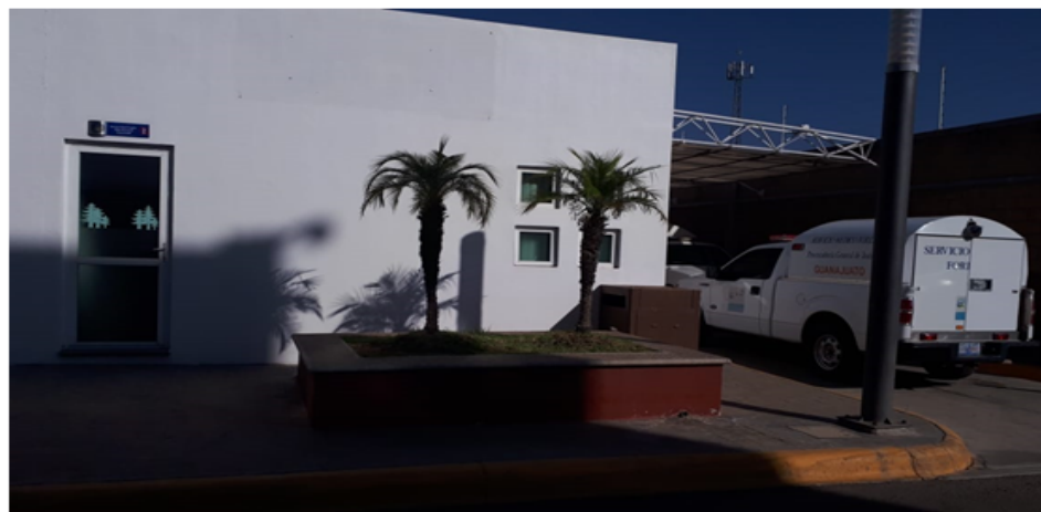
Figura 5. Instalaciones del SEMEFO de Guanajuato: vista general.
