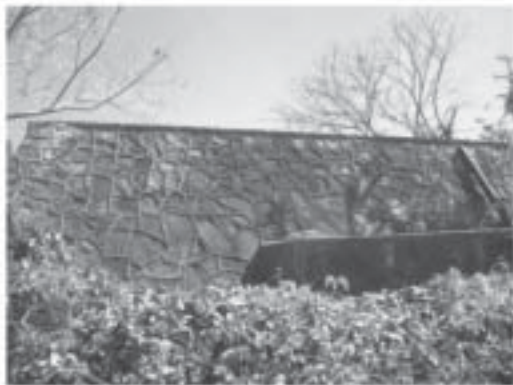
Tanques de agua de cabecera
