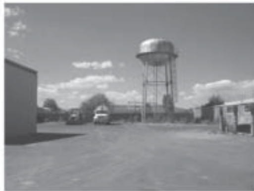
Tanque elevado de agua potable
