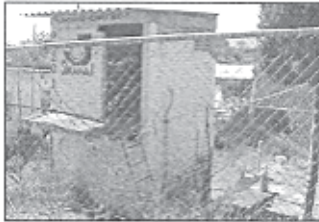
Pozo No. 1 "Capitiro"
