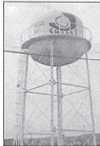
Tanque Elevado No. 2 Jaral
