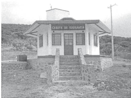
Figura 1.5.6. Fachada de la caseta de vigilancia
