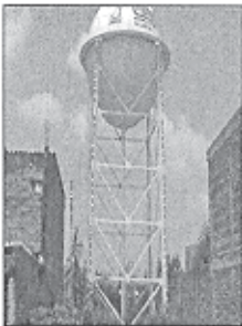
Tanque Elevado No. 1 Jaral
