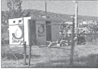
Pozo No. 4 "CETIS"
