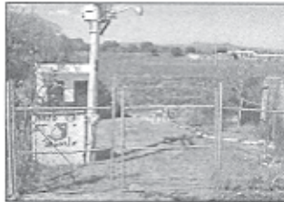
Pozo No. 2 "Capitiro"
