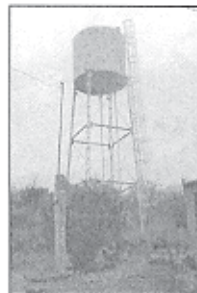
Tanque Elevado No. 3 Jaral
