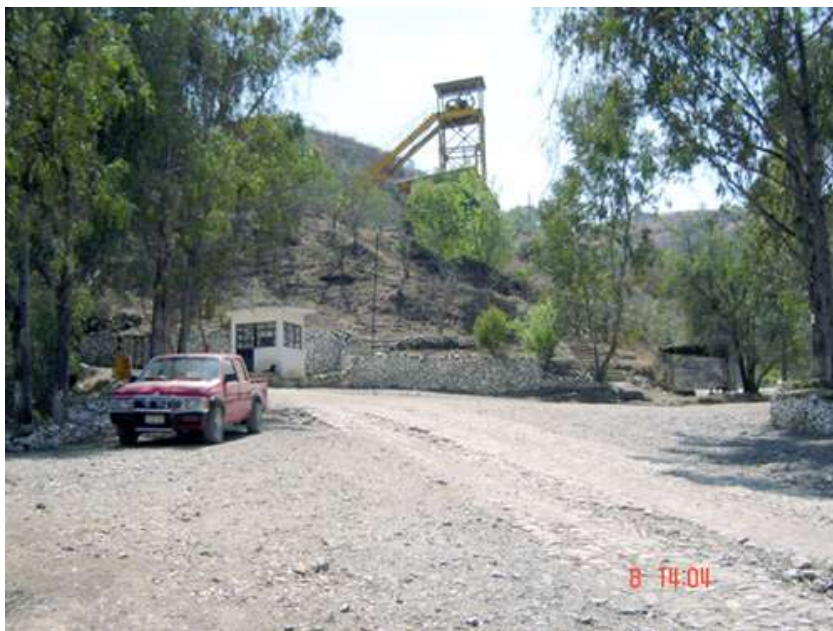
Fotografía 17. Mina "La Luz" Unidad Bolañitos. Plomo, plata y oro en operación
