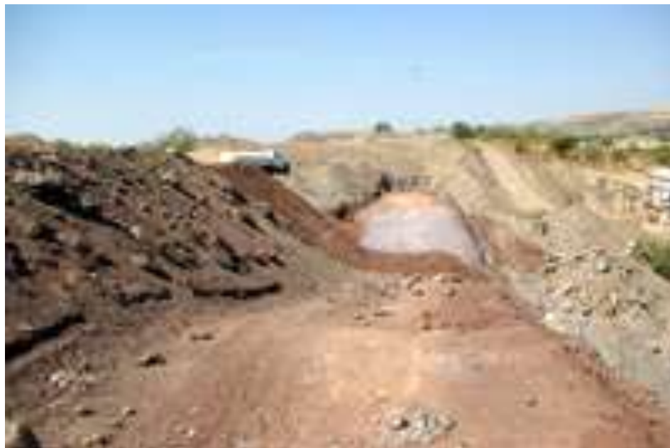
Fotografía 13. Talud con posibilidad de generar flujos de lodo con afectación a viviendas
